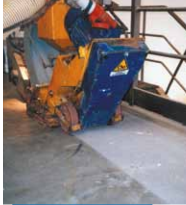
Préparation du support par grenailage
