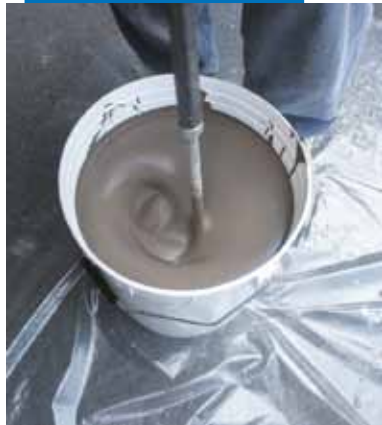
Préparation du produit avec un malaxeur
