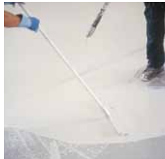
Application mécanique d' Ultratop
