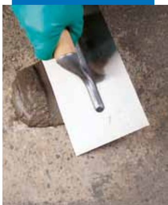
Rebouchage sur un sol en béton
