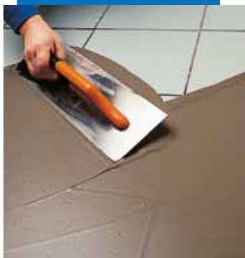
Application sur carrelage après gâchage avec Latex Plus
