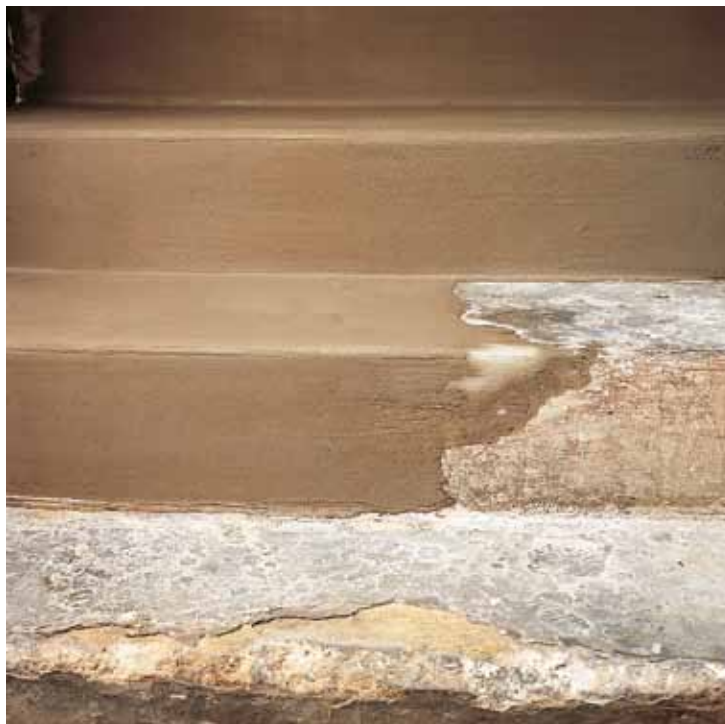
Gradins avant et après la rénovation avec Nivorapid
