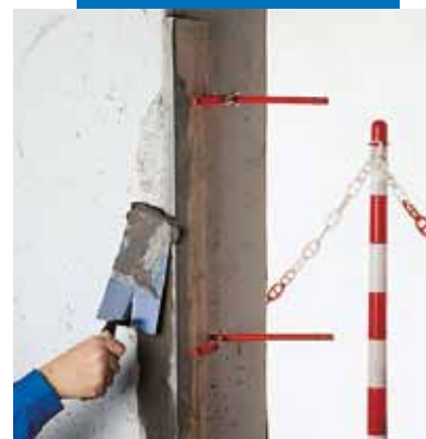
Réparation d'une arête
