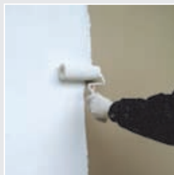
Application du CRÉPIFOND G
