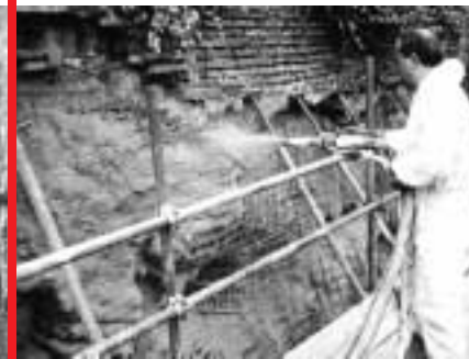
Béton projeté avec S8 SMART
