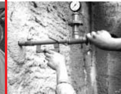
Injection de coulis de ciment
