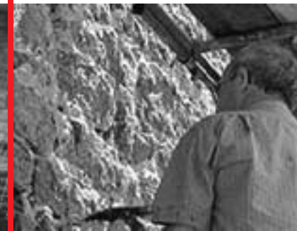
Réalisation d'un rejointoiement
