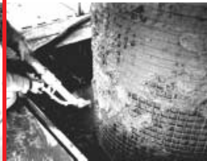
Projection de mortier fibré
