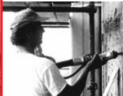
Application d'enduit pré-mélangé
