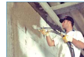
Projection d'enduit
