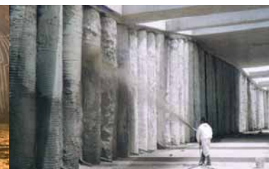
Béton projeté dans un tunnel
