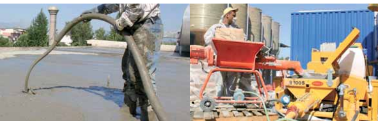
Pompage de béton cellulaire
