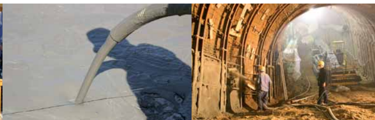
Pompage de béton cellulaire
